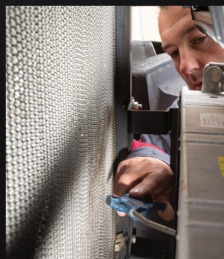
Pietiekami daudz vietas, lai piekļūtu radiatoriem un veiktu tīrīšanu.
